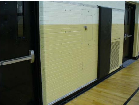
Missing Gymnasium Wall Padding
